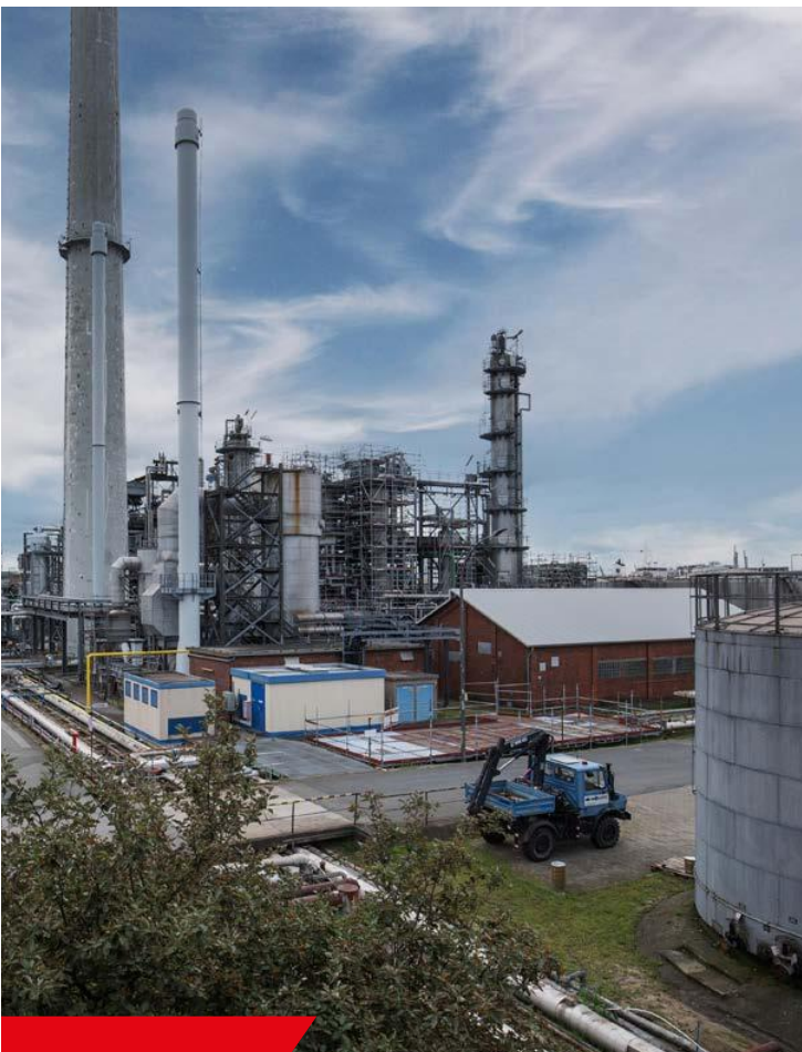
Abb. 22: Elektrolyseur bei H&R Ölwerke Schindler im Hamburger Hafen © Mediaserver Hamburg / DOUBLEVISION / Konstantin Becker
