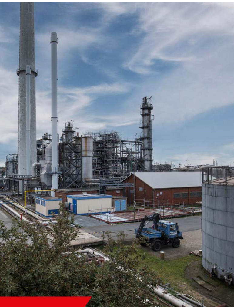
Abb. 38: Elektrolyseur bei H&R Ölwerke Schindler im Hamburger Hafen © Mediaserver Hamburg / DOUBLEVISION / Konstantin Becker
