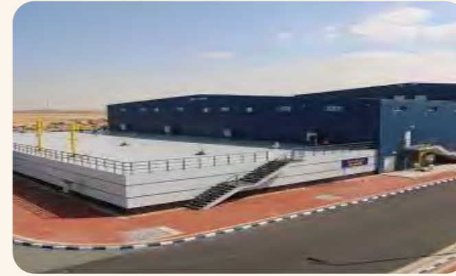
محطة تحلية مياه البحر بالشرق
