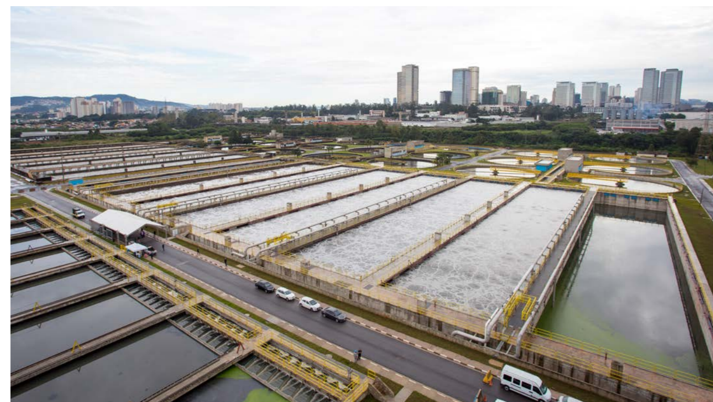
Estação Elevatória de Esgoto Piqueri.
