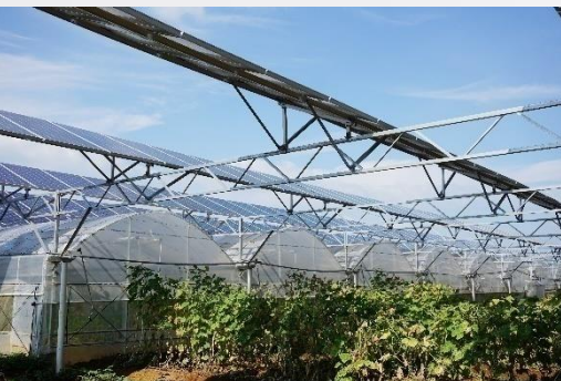
光伏农场●大棚农业（现场实拍） PV Farm ● Greenhouse
