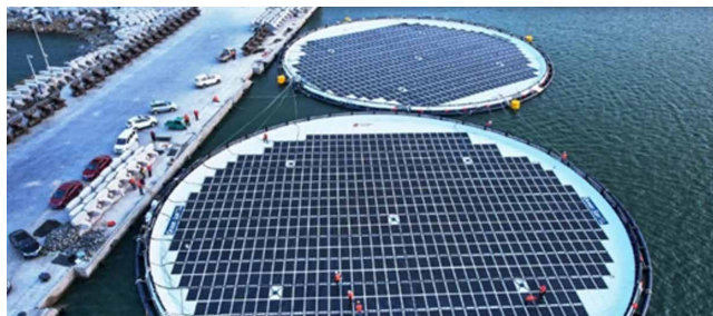
国家电投山东半岛南3号海上风电场20兆瓦深远海漂浮式光伏500千瓦项目，为全球首个投用的深远海风光同场漂浮式光伏实证项目 来源：国际电力网 82
