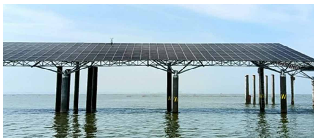
山东文登HG32海上光伏实证科研项目，该项目为全国首个固定式长桩基海上光伏实证科研项目 来源：威海市文登区人民政府 83
