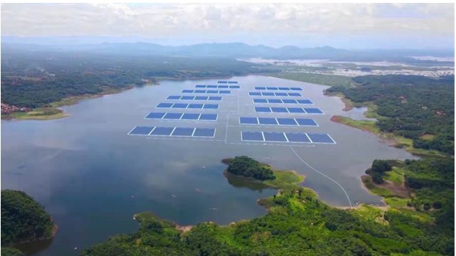
图 5-2 位于印度尼西亚的奇拉塔（CIRATA）漂浮式光伏电站
