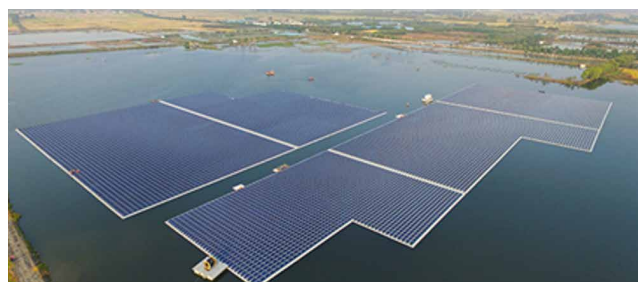
于2018年并网发电的三峡集团安徽淮南150MW水面漂浮光伏项目，为彼时全球最大的水面漂浮电站 来源：澎湃新闻 84
