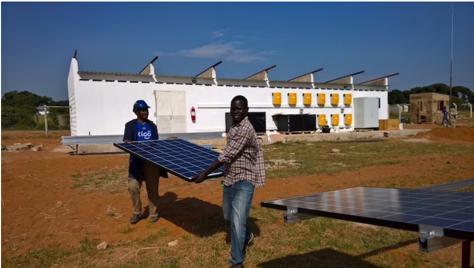
图 6-3 坦桑尼亚工人正在安装光伏微电网设备
