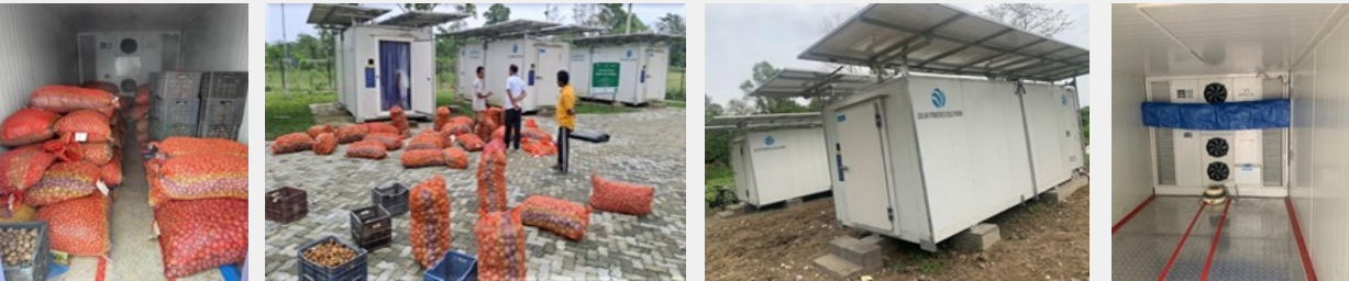
图 4-6 印度阿萨姆邦便携式太阳能冷藏设施
