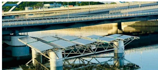
SolarDuck在东京湾建设的海上漂浮式光伏组件，为日本首个海上漂浮式光伏装置 来源：solarduck.tech
