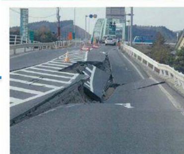
⑫国道45号 路面崩壊 (宮城県石巻市)
